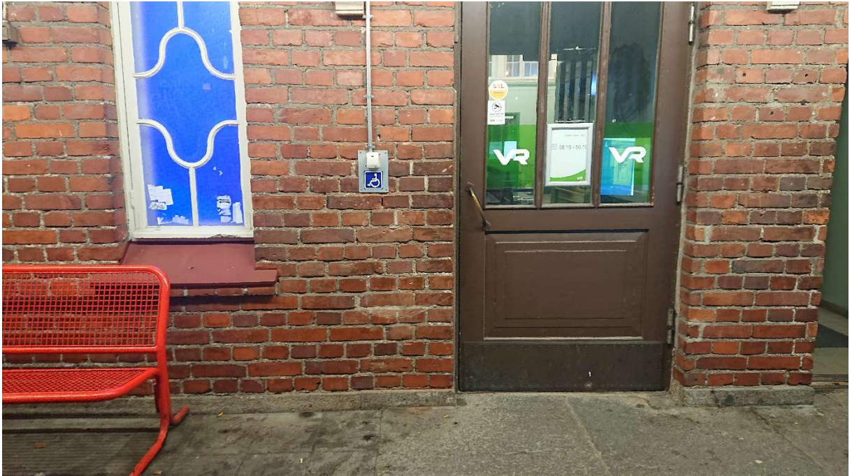
Kuva 9. Esteetön sisäänkäynti laiturilta 1 asemarakennukseen.
